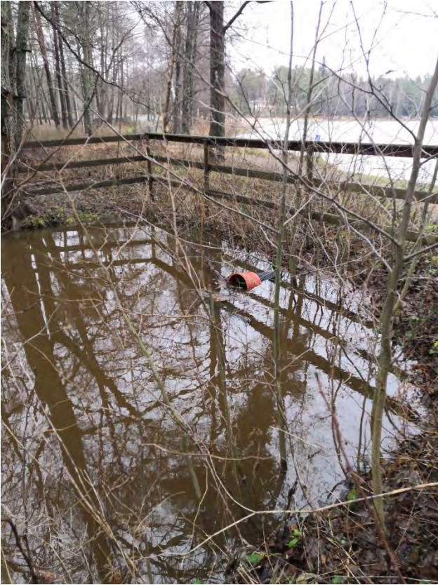
7. Muurikinkadun pää, laskeutusaltaalta lähtevä putki.
