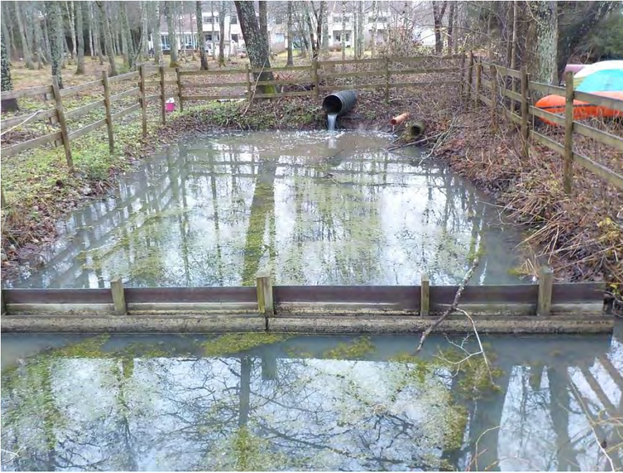
14. Rullakadun eteläpuoli, laskeutusaltaasta lähtevä vesi
