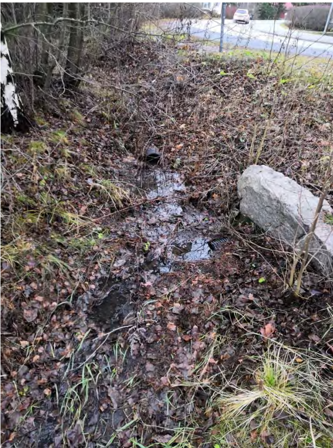
10. Vanha Littoistentie, putki 3
