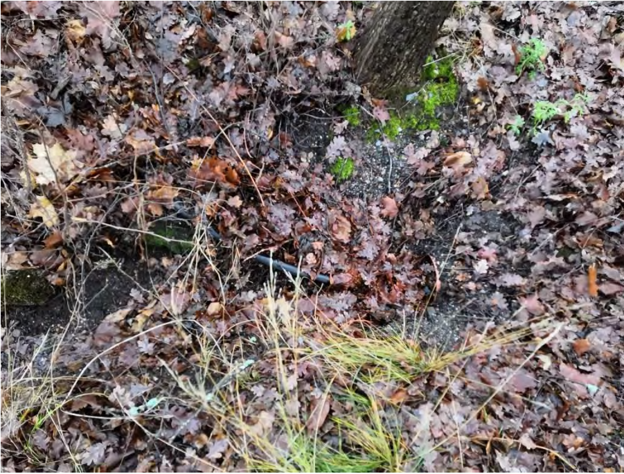
9. Vanha Littoistentie, putki 2
