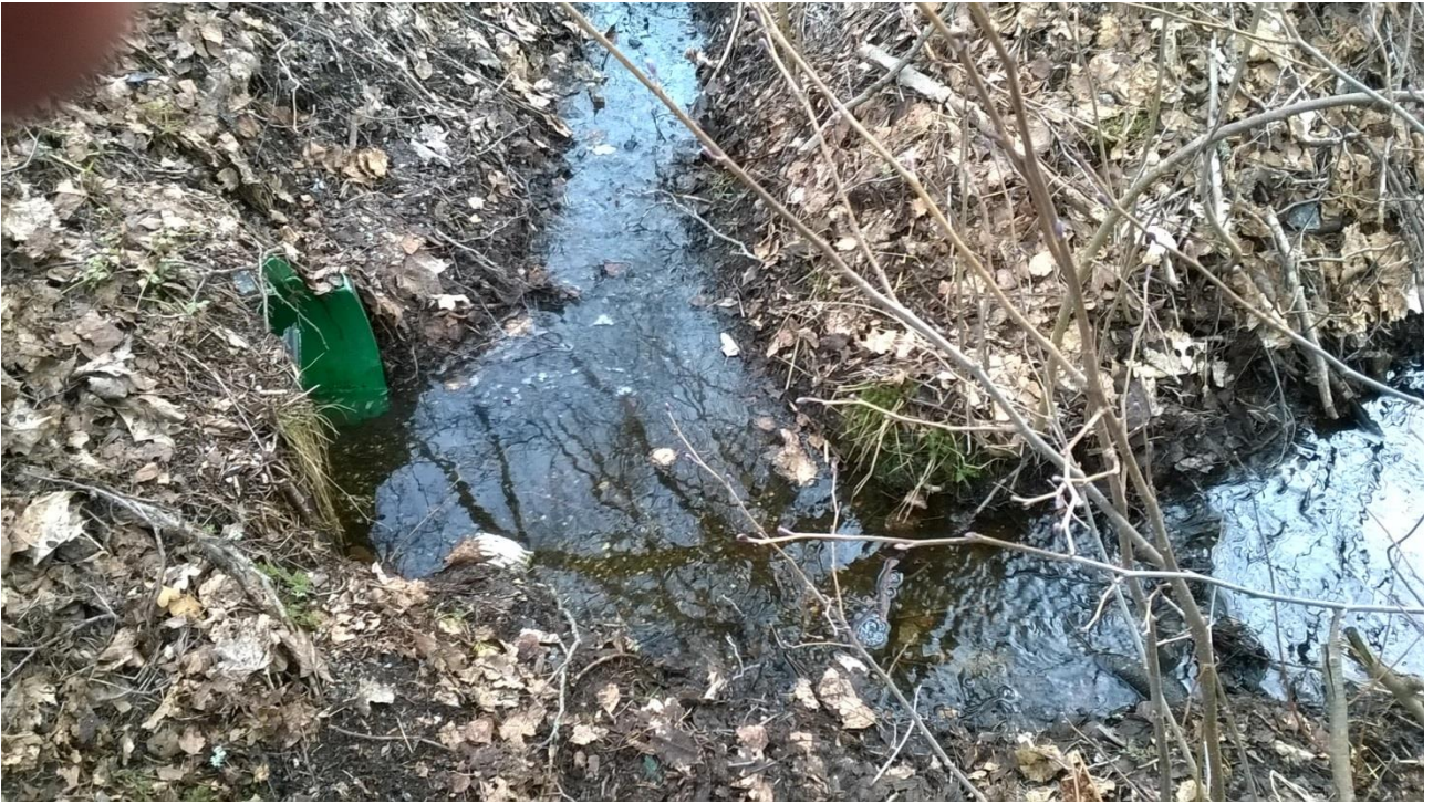
9. Vanha Littoistentie, putki 2
