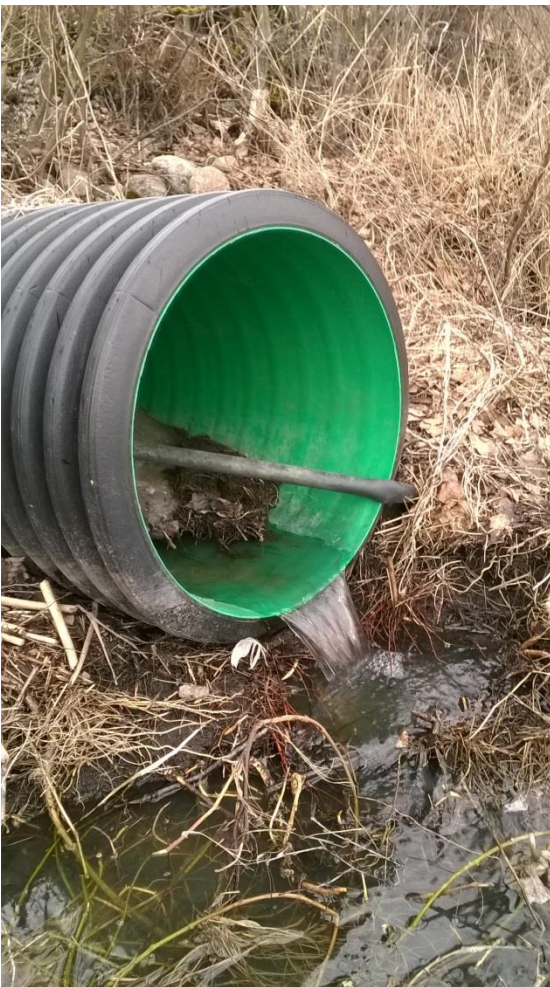
8. Vanha Littoistentie, putki 1
