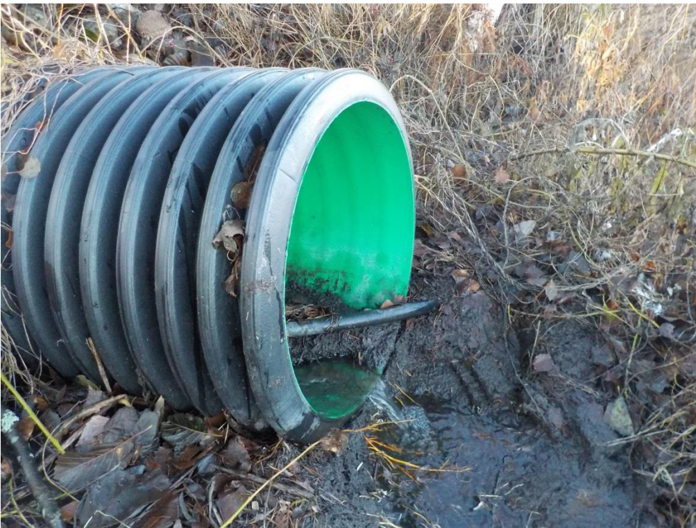
8. Vanha Littoistentie, putki 1
