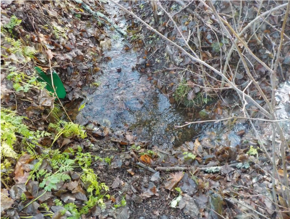
9. Vanha Littoistentie, putki 2
