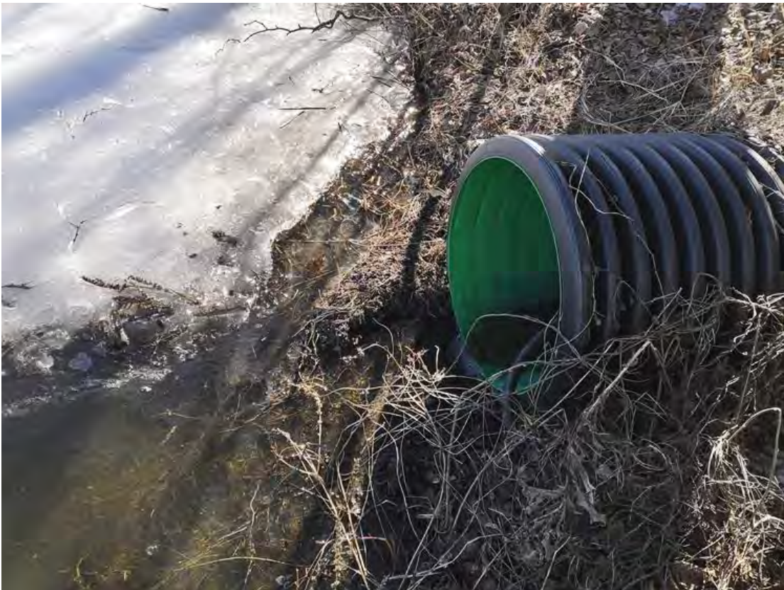
8. Vanha Littoistentie, putki 1
