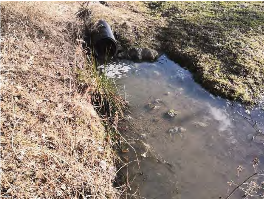
11b. Punttikadun pohjoispuoli, hulevesiputki
