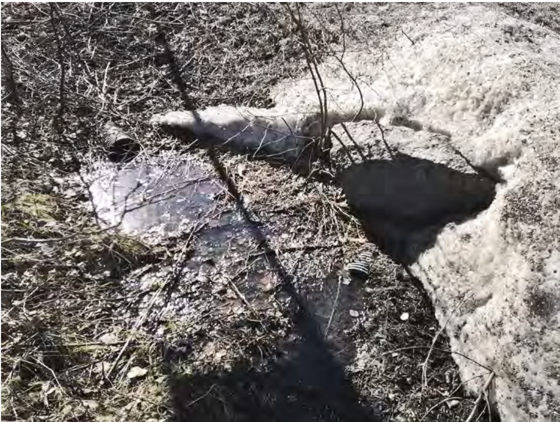
10. Vanha Littoistentie, putki 3
