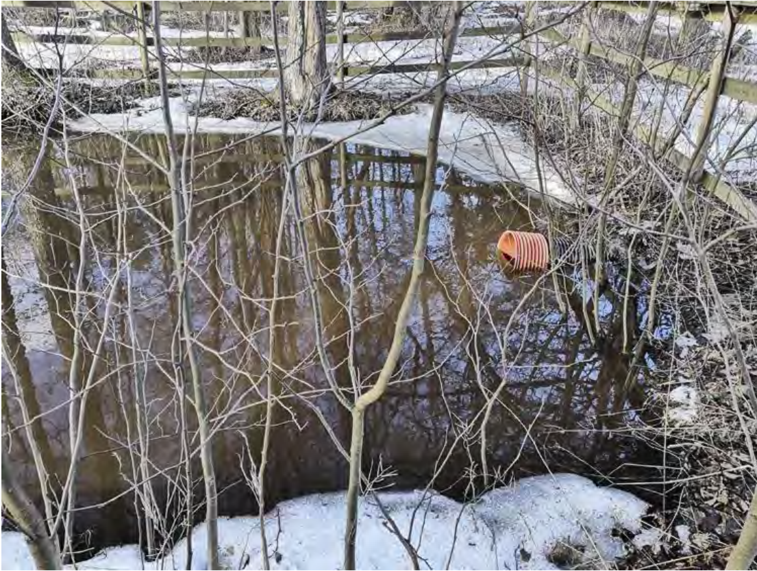
7. Muurikinkadun pää, laskeutusaltaalta lähtevä putki.
