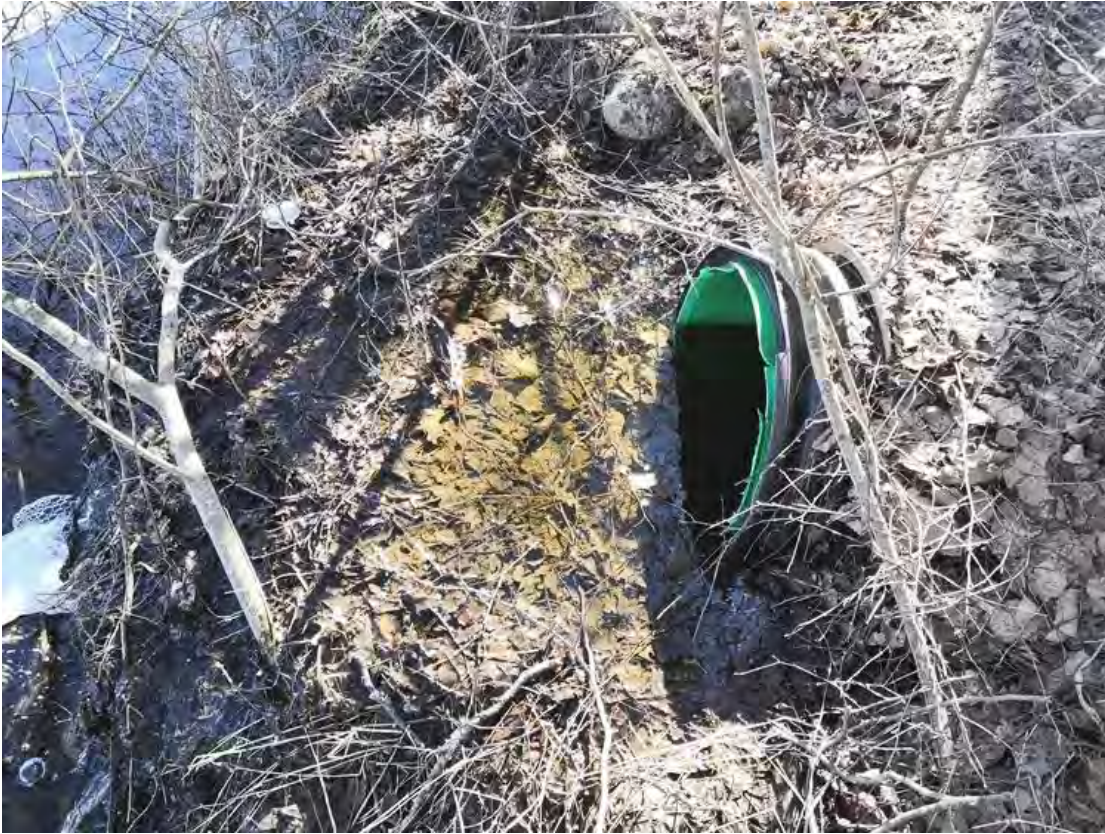
9. Vanha Littoistentie, putki 2
