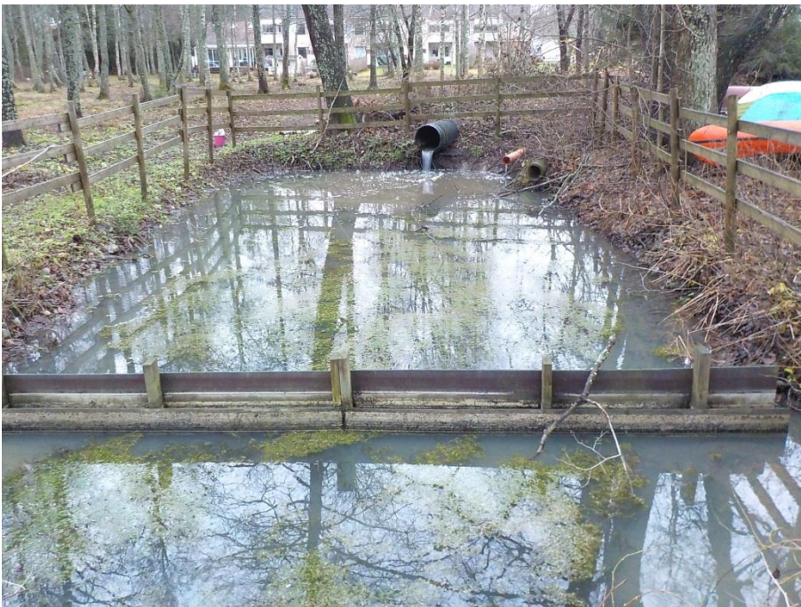
14. Rullakadun eteläpuoli, laskeutusaltaasta lähtevä vesi
