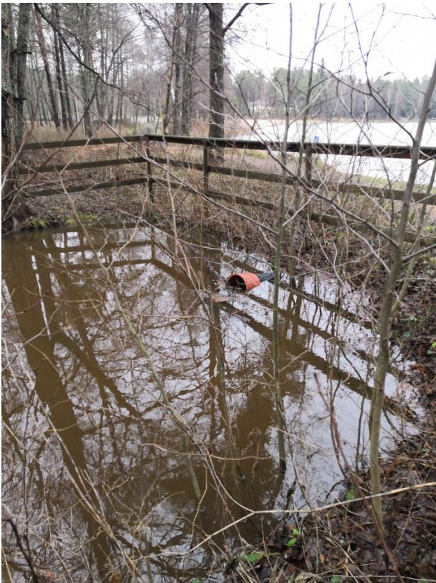
7. Muurikinkadun pää, laskeutusaltaalta lähtevä putki.
