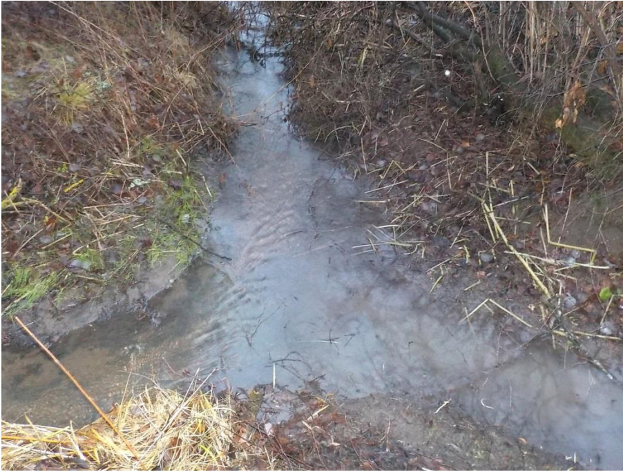
11b ja 11c. Punttikadun pohjoispuoli, havaintopaikkojen 11b ja 11c alapuolinen ojaristeys
