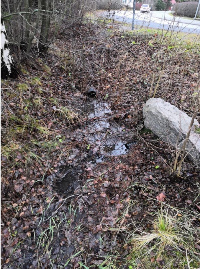
10. Vanha Littoistentie, putki 3
